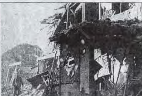
1945年1月16日夜の空襲で破壊された下馬町の民家。故長谷川哲也さん撮影／写真提供・宮川友治さん
