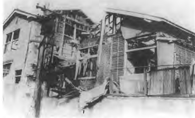
爆風で壊れた幼稚園舎 (昭和20年)
