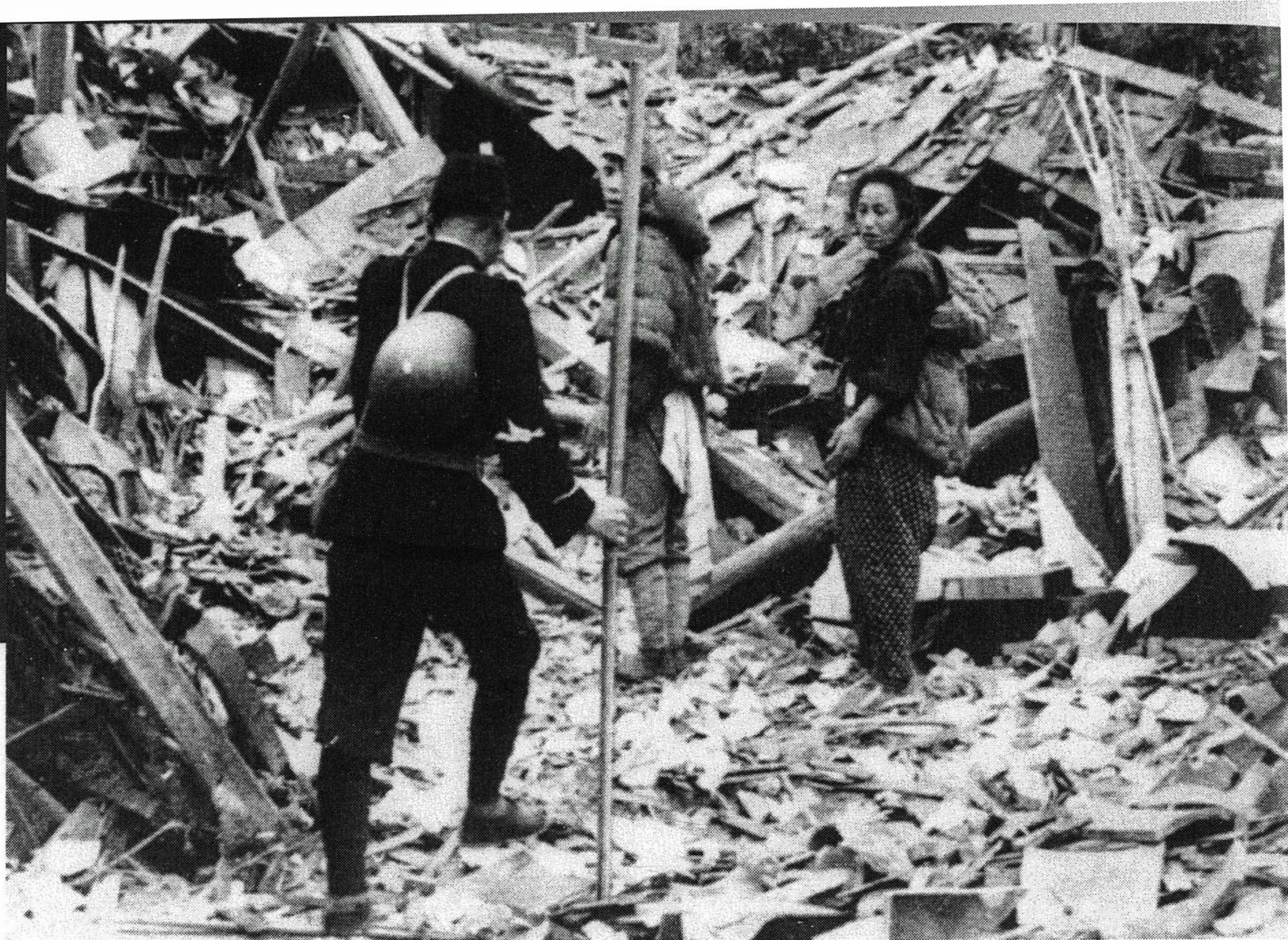
■日本の伝統文化を数多く残す古都・京都にも空襲の魔の手は伸びた。写真は京都・上京区の住民が撮影した空襲被災地。
